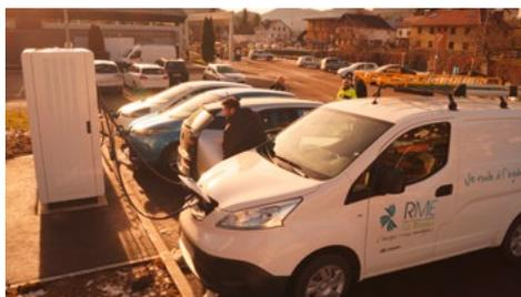
▲ Installation d'une nouvelle borne électrique avec la possibilité de charger 4 véhicules simultanément
