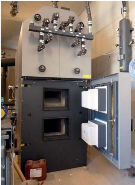
La seconde, de dix ans plus moderne, est plus complexe : elle est équipée d'un ballon tampon de 18000 litres, d'un économiseur qui récupère une partie des calories des fumées, d'un dépoussiéreur cyclonique pour le traitement des fumées, et d'un électrofiltre pour piéger les microparticules. D'une puissance de 500 kW, elle a un meilleur rendement, même avec des plaquettes plus humides (35 à 41 % d'humidité selon la saison) et de granulométrie grossière.
