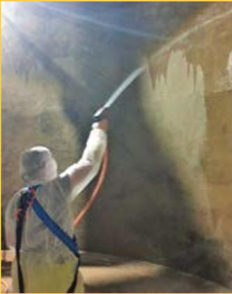
Nettoyage annuel des réservoirs d'eau qui est une obligation sanitaire : 17 cuves de stockage de volume compris entre 10m<sup>3</sup> et 600m<sup>3</sup>.
